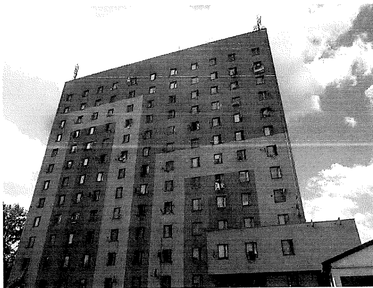
Zał. nr 1: Widok ogólny instalacji radiokomunikacyjnej.
