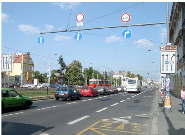
Rys. 3.1-1. Wydzielenie ogólnodostępnego pasa do skrętu w prawo poza pasem autobusowym (Praga, Czechy, opracowanie własne).
