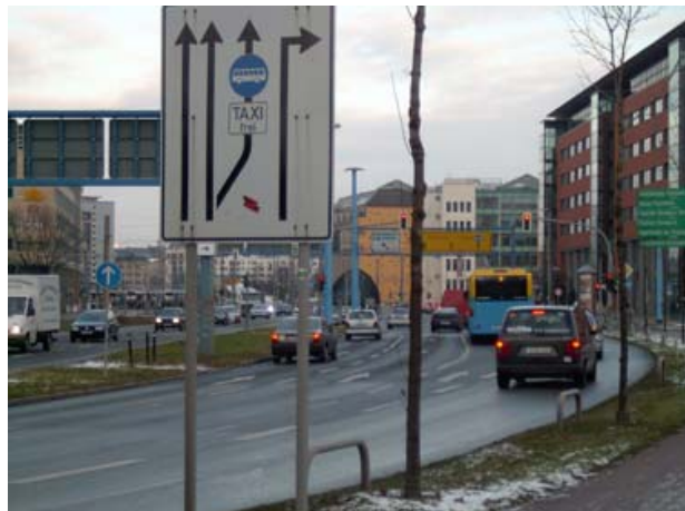
Rys. 3.1-2. Pas autobusowy do jazdy na wprost na wlocie skrzyżowania, utworzony pomiędzy pasami ogólnodostępnymi (Chemnitz, Niemcy, opr. własne).
